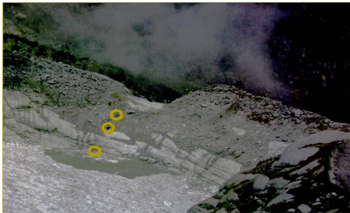
Figura 6. Borde libre y las conexiones al túnel de descarga. La diferencia de nivel entre el nivel del espejo de agua y la coronación del dique rocoso es de 20 metros.
