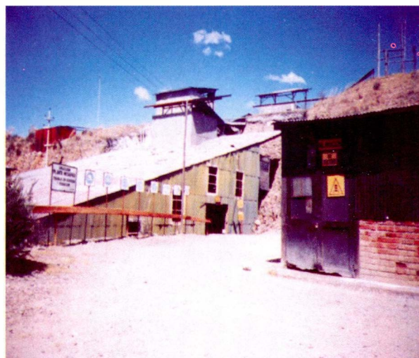
Figura 2. Planta Concentradora de Mesapata.
