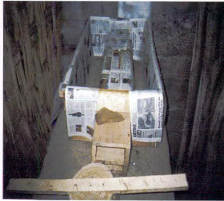
11.- Después de untar con aceite, se forra con papel periódico para que la mezcla especial no se pegue.
