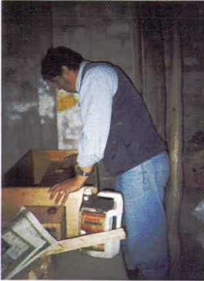
10.- Untando con aceite la parte interna del molde.
