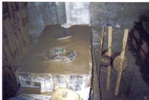
14.- Después de tres días que secó se empezó a retirar la 03 matriz (chimenea, 1º hornilla y 2º hornilla).
