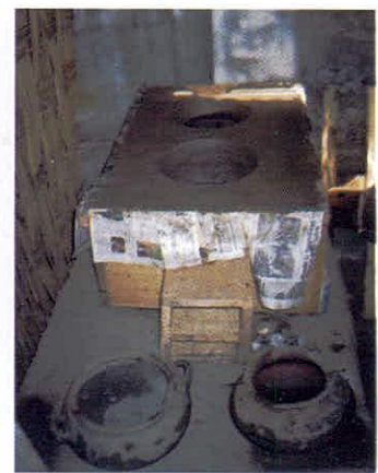
15.- Con una olla de 25cm nos sirve para moldear las hornillas (Base de las ollas).
