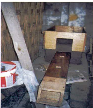
16.- Posteriormente una vez secado de 04-05 días, se procedió a retirar el cajón, la base de la cámara de combustión.
