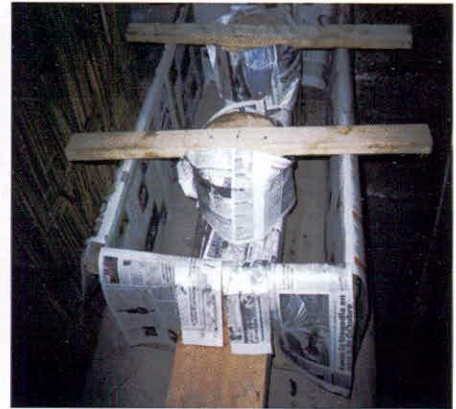
12.- Vista de planta del molde listo para el llenado
