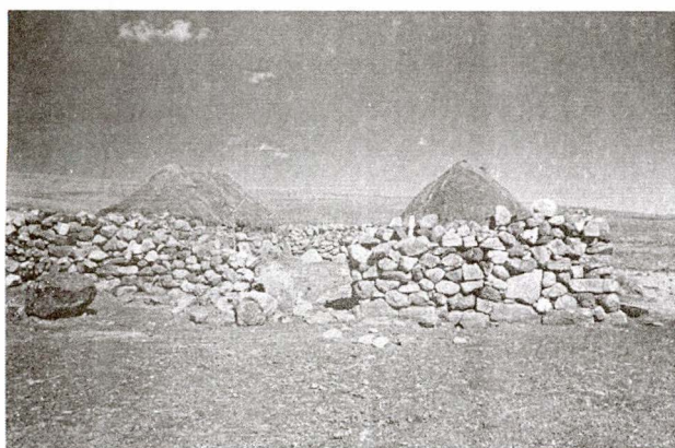
Fotografía N° 4: Una vivienda típica de la Comunidad Campesina de Cátac, construida con piedras y techada con paja, se encuentra localizada en lugar denominado Uchpacancha-Pampajalca, 2006.
