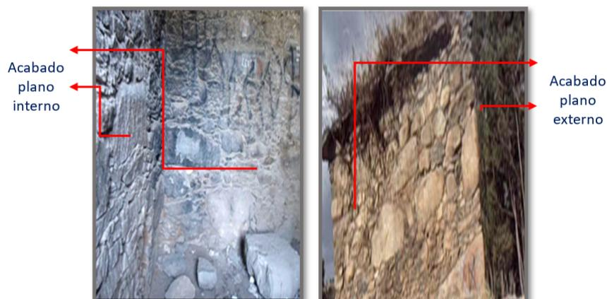
**Piedra con un espesor de 2-6cm, con longitud de 30cm y un ancho de 20cm promedio (tipo 3).** Este tipo de piedra de forma de paralelepípedo, que se le podría decir placa de piedra mediana, otorgan un plano estable a las piedras que son puestas para aumentar el tamaño del muro.
