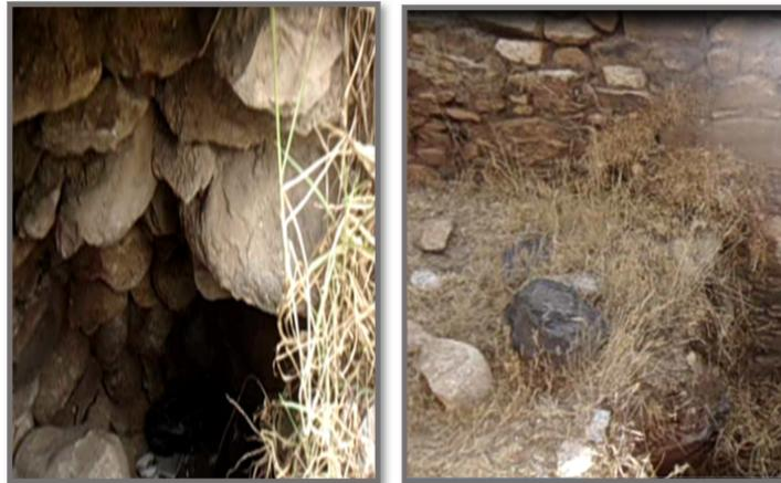
El sobrecimiento constituye la parte de la cimentación que se construye encima de los cimientos y que sobresale de la superficie del terreno. Está conformado por los tres tipos de materiales identificados. El sobrecimiento es una plataforma de aproximadamente 1,1 m por encima del suelo, y sobre esta plataforma se elevan los muros.
