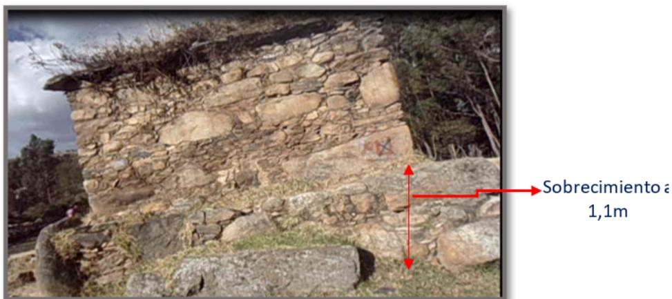
El muro es construido con los cuatro tipos de piedra: tipo 1, tipo 2, tipo 3 y tipo 4. Para poder consolidar la unión de estas piedras se hace uso de la masa de tierra como material de confinamiento. Los muros poseen una altura de 1,80 m a 2,20 m.
