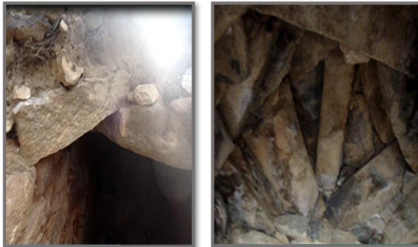
Este tipo de piedras también son utilizadas en las esquinas, en los pilares de la construcción, otorgando mayor estabilidad a los puntos nodales de la construcción. También se colocan a media altura de los muros, en las bases de las construcciones de muros y el sobrecimiento continuo.
