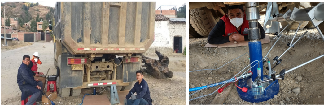
Ejecución del ensayo de placa de carga y sus componentes del ensayo
