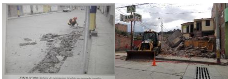
Demolición de estructuras de albañilería en edificación
