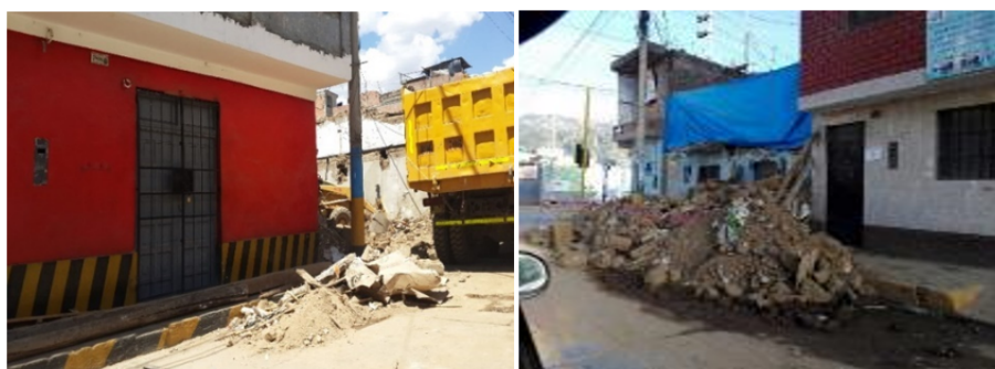
Demolición de Construcción de Adobe
